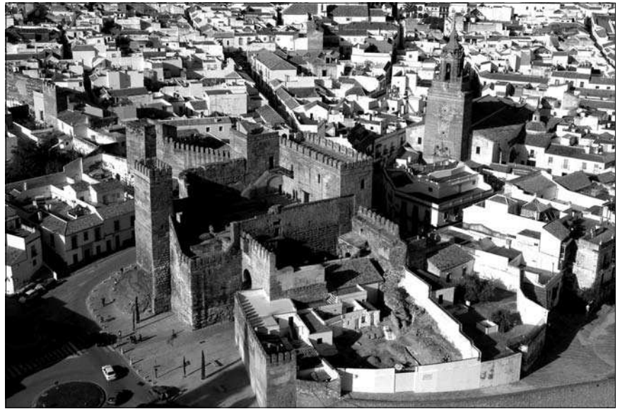
FIGURA 12.—Vista aérea de la Puerta de Sevilla, en Carmona (Sevilla).
