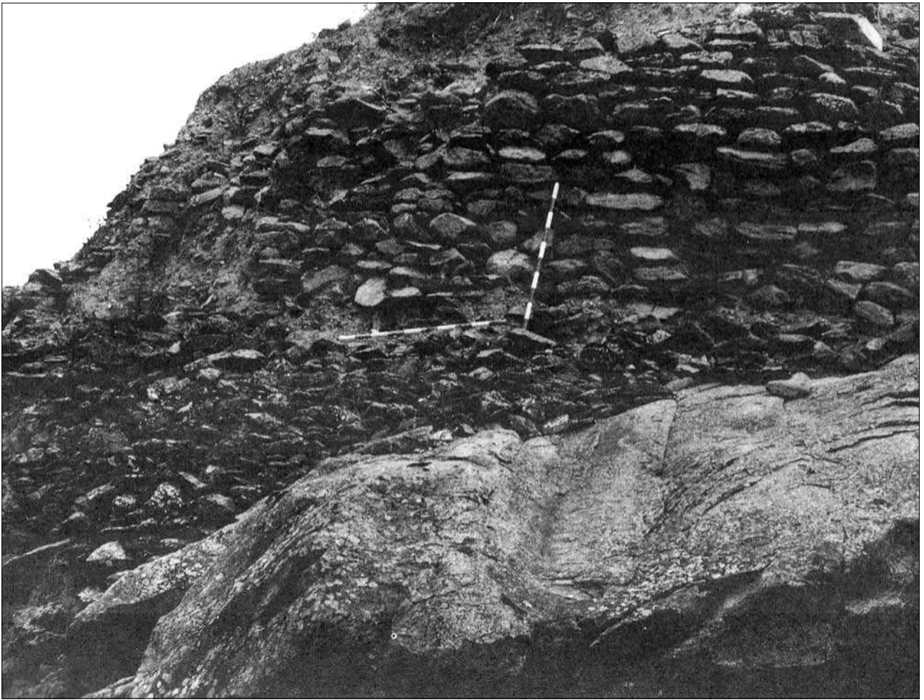
FIGURA 1.—Muralla del Bronce Final de El Castillo de Aznalcóllar (según Hunt 1995).
