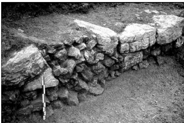
FIGURE 24.—Le mur de berge du premier état du rempart de Besançon.
