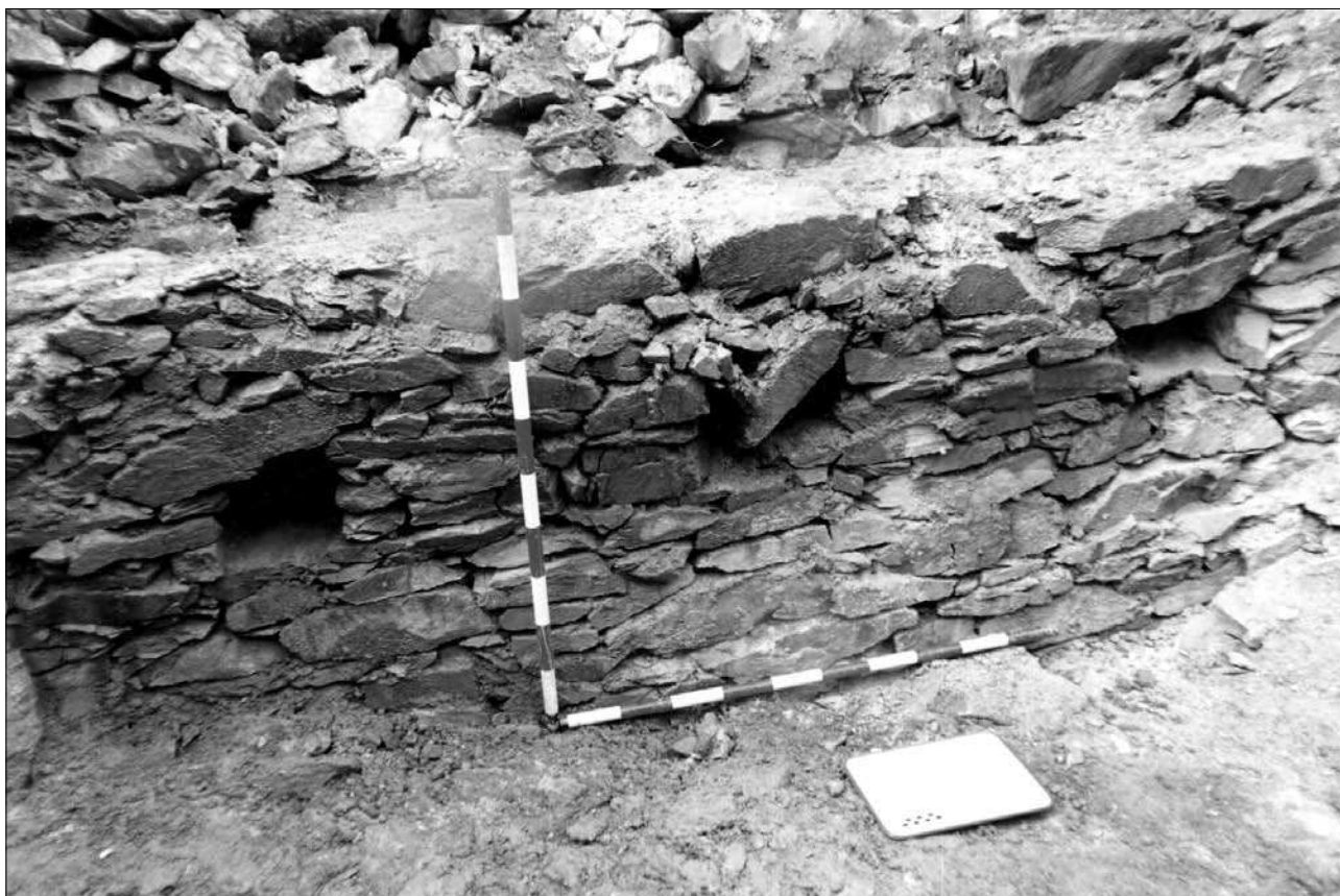
LÁMINA 3.—1: Bastión y muro proyectado al exterior; 2: Muro con agujeros de vigas, a lo «gálico», en el interior del bastión. Deben responder a «mechinales» de apoyo al primer piso. No se pudo profundizar más.
